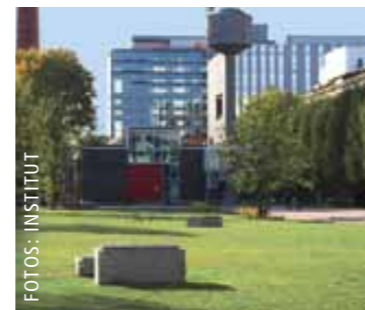
Brunnenschächte eines Aquiferspeichers auf dem Campus der TU Eindhoven
