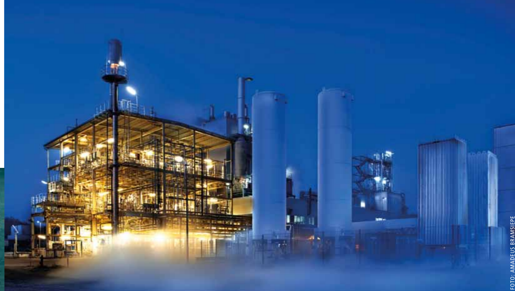
In der bioliq-Anlage auf dem Campus Nord des KIT wird daran geforscht, aus Reststoffen wie Stroh und anderen trockenen pflanzlichen Bestandteilen alternative Kraftstoffe herzustellen The bioliq facility on KIT Campus North conducts research to produce alternative fuels from residual materials, such as straw and other dry plant constituents
